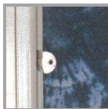
Particolare della serratura
